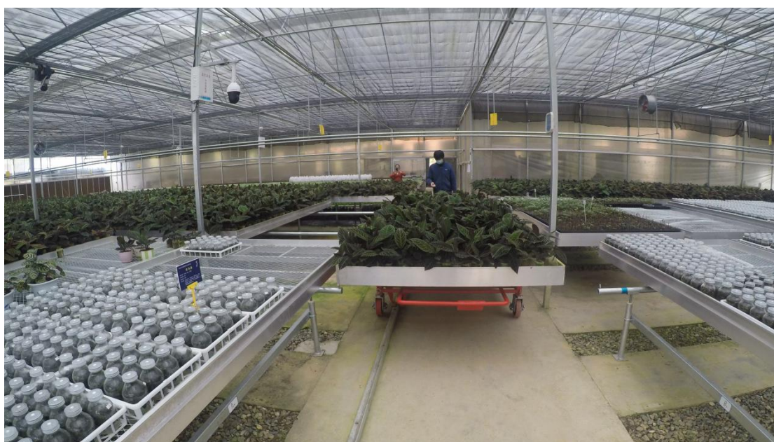
温室内部大型移动苗床搬运车遥控搬运
